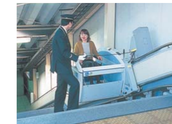
輪椅爬梯機 車いす用階段昇降機
